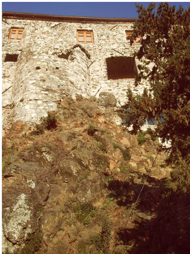
Casa-torre: resti dell'antica cinta muraria di Bibola.
