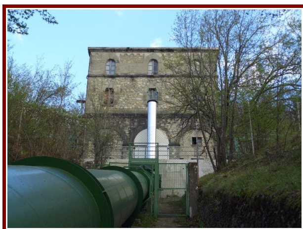
Arlia, la casa del guardiano sopra le vasche di carico e la condotta forzata
