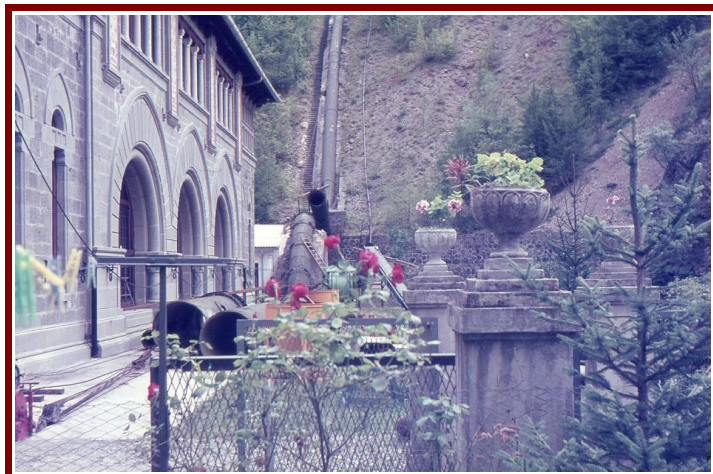
Arlia, 1964. Lavori di sostituzione della primitiva condotta forzata in ghisa.
