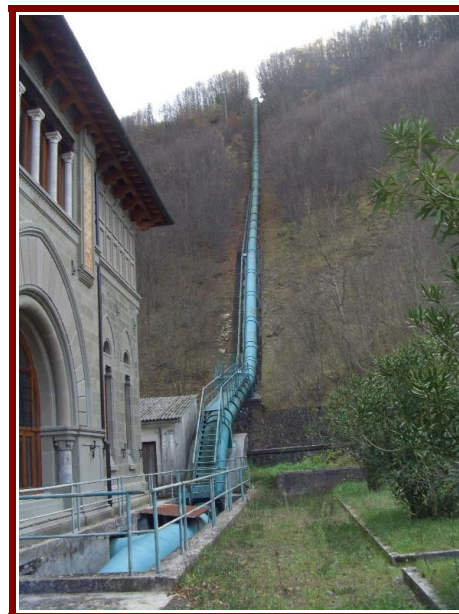
Arlia, scorcio della centrale e della condotta forzata
