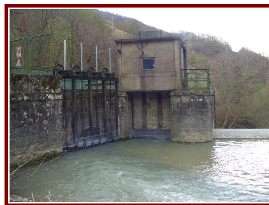
In alto lo sbarramento o traversa sul Rosaro in località Matucaso
