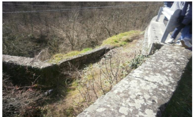
Canale di adduzione
